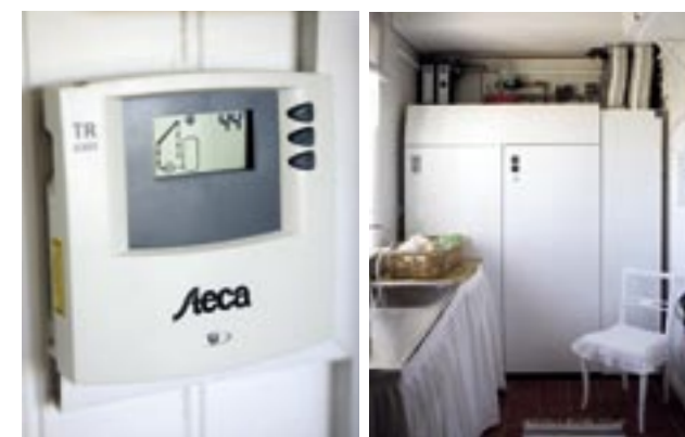
NEDAN HÖGER I kläddvårdsrummet står de två ackumulatortankarna på 500 liter var. Systemet sköter sig själv men då det är kallt på vintern måste man elda i kakelugnen en gång om dagen.
