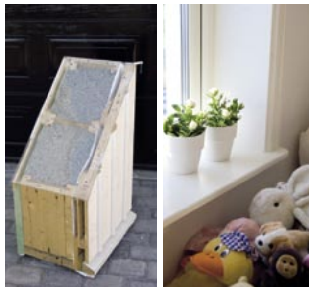
VÄNSTER Så här ser konstruktionen av väggen ut med råspont, ångbroms, cellulosaisolering och lättreglar. HÖGER I Felicias rum kan man på den djupa fönstersmygen tydligt se hur tjocka väggarna är med sina trettio centimeter av cellulosafyllning.
